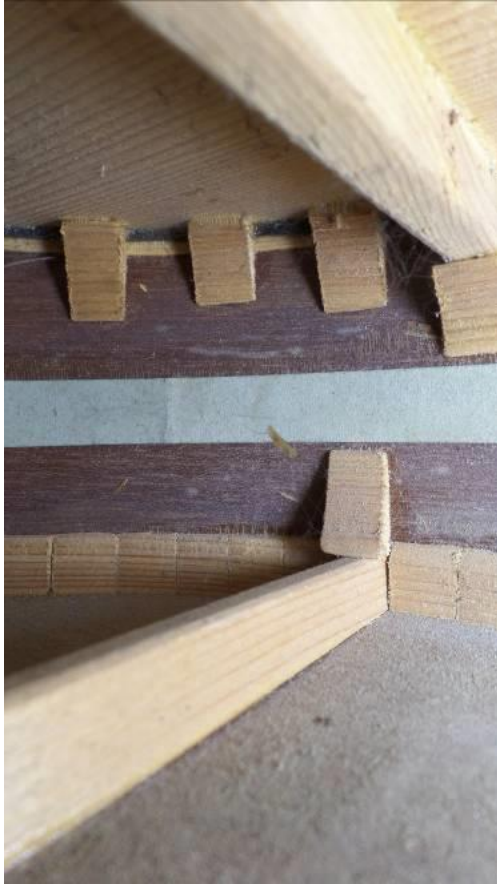
Ilustración 252: Vista de los refuerzos interiores
