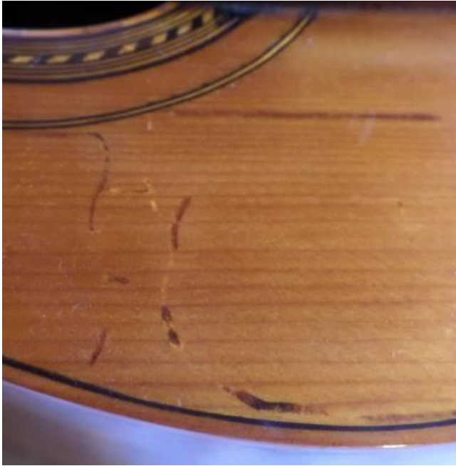
Ilustración 217: Túneles de xilófagos
