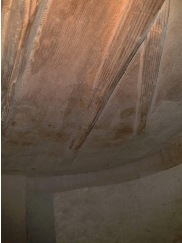
Ilustración 104: Vista interior del sistema de refuerzo del abanico
