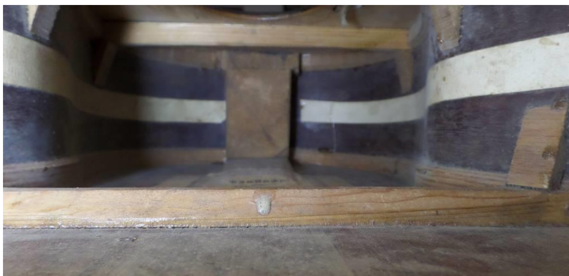
Ilustración 145: Fotografía interior tomada desde la culata
