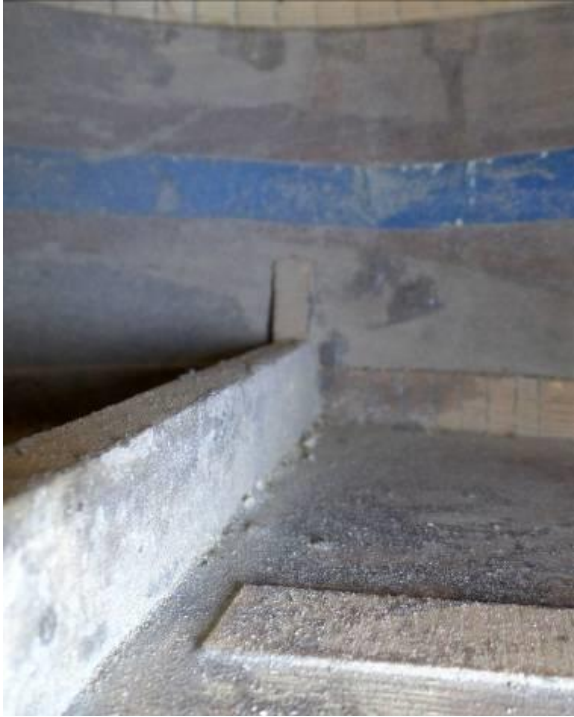
Ilustración 225: Barra de fondo apoyada en un peón triangular
